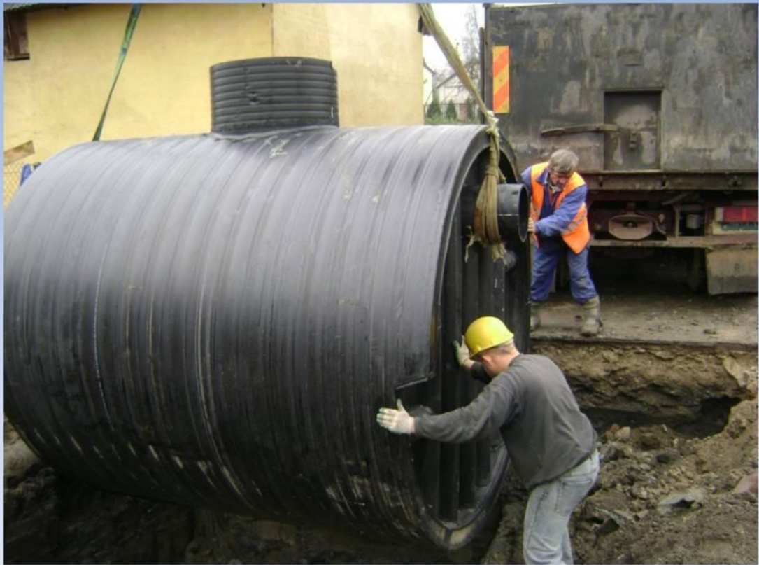
Budowa OWD - ul. Zrębińska
