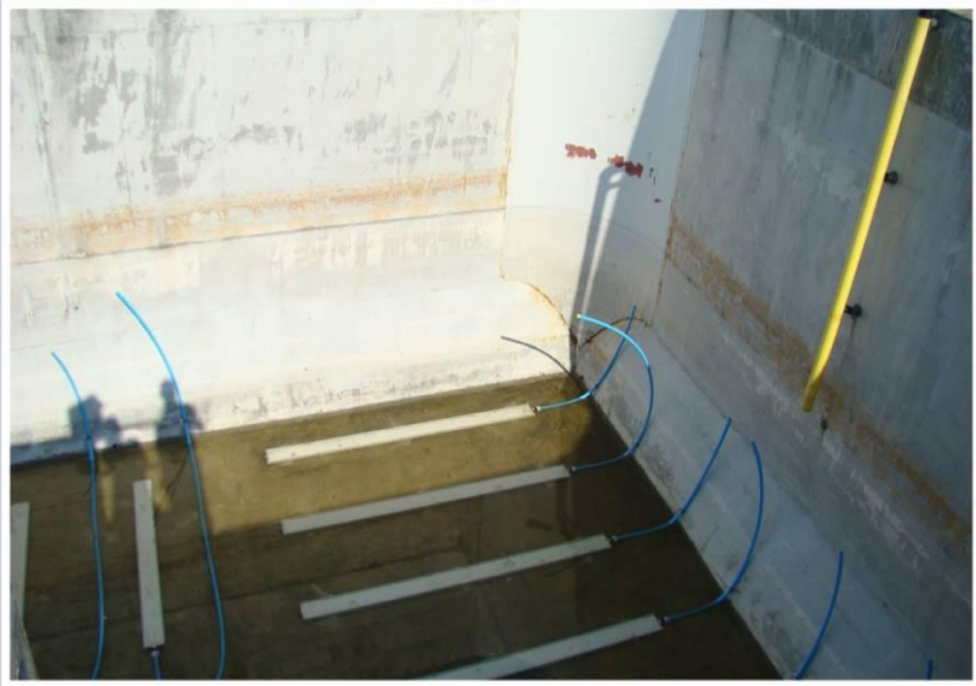
Montaż dyfuzorów panelowych
