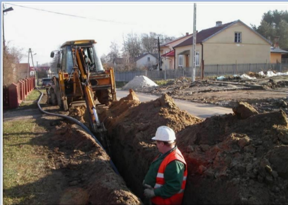
Ułożenie rurociągu kanalizacji w wykopie
