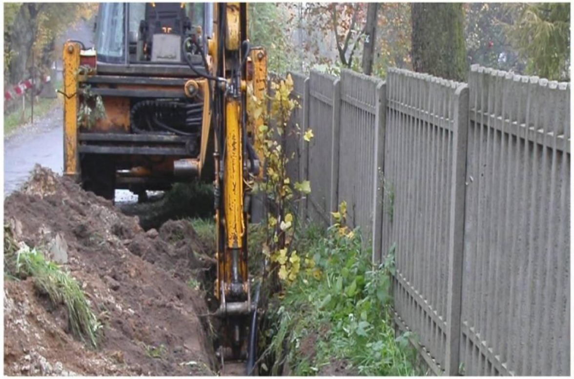
Wykop i układanie rurociągu
