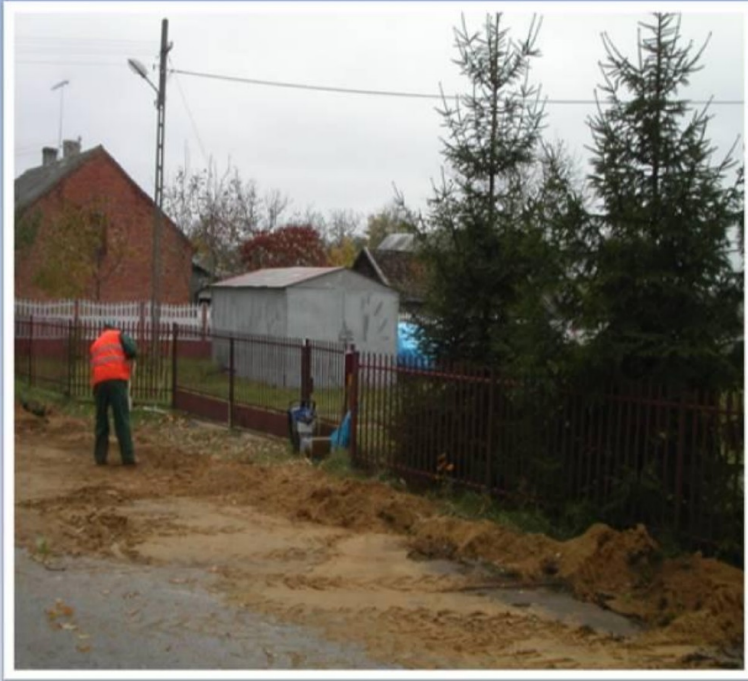
Zasypanie i zagęszczenie wykopu po wykonanej kanalizacji
