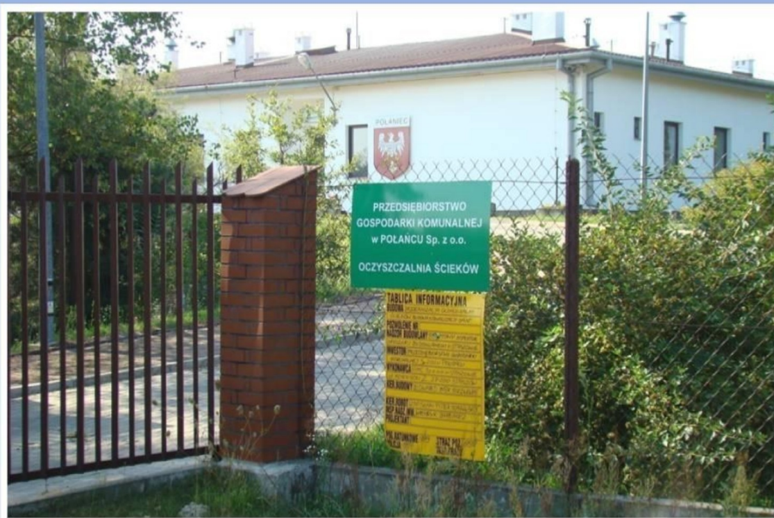
Budynki Oczyszczalni po wyremontowaniu zniszczonej elewacji
