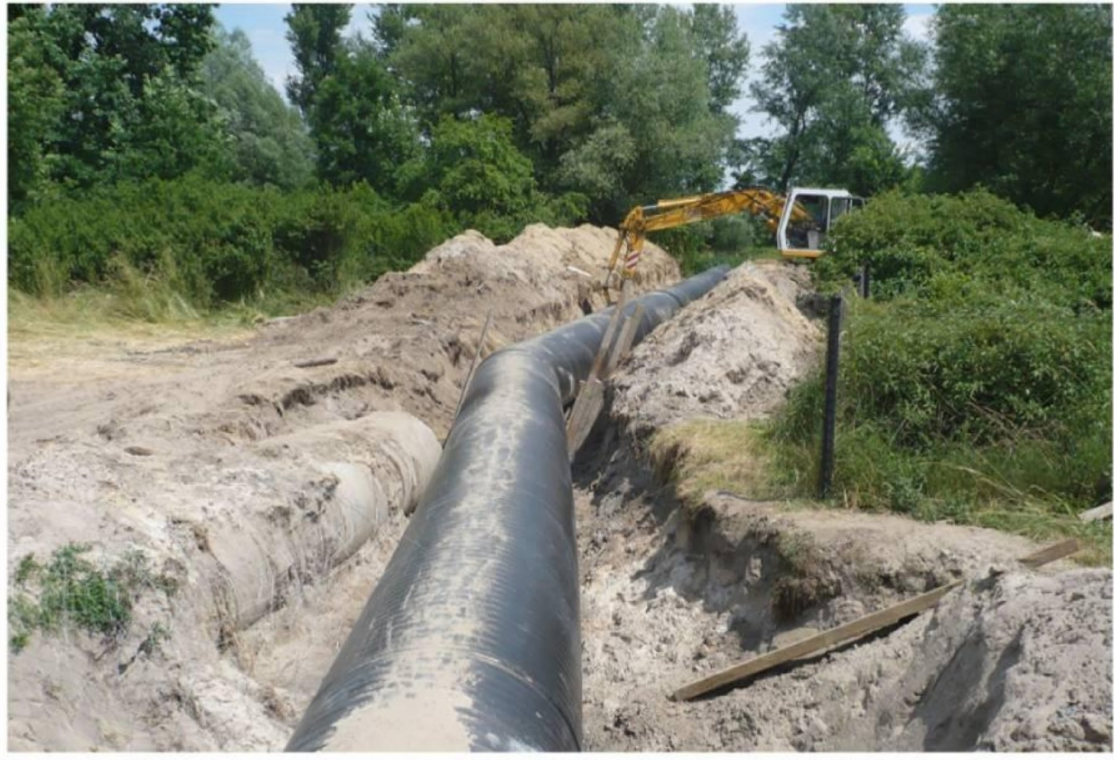
Budowa OWD na ul. Partyzantów
