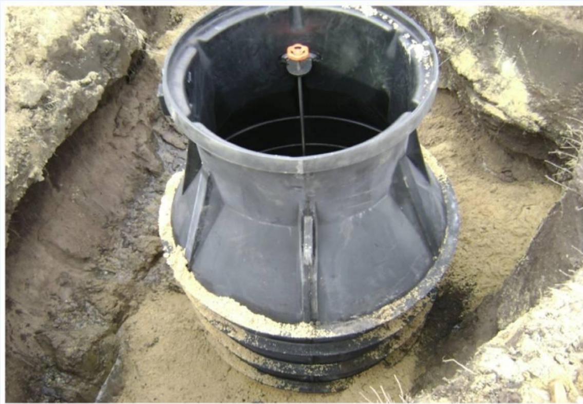
Montaż studni przydomowej
