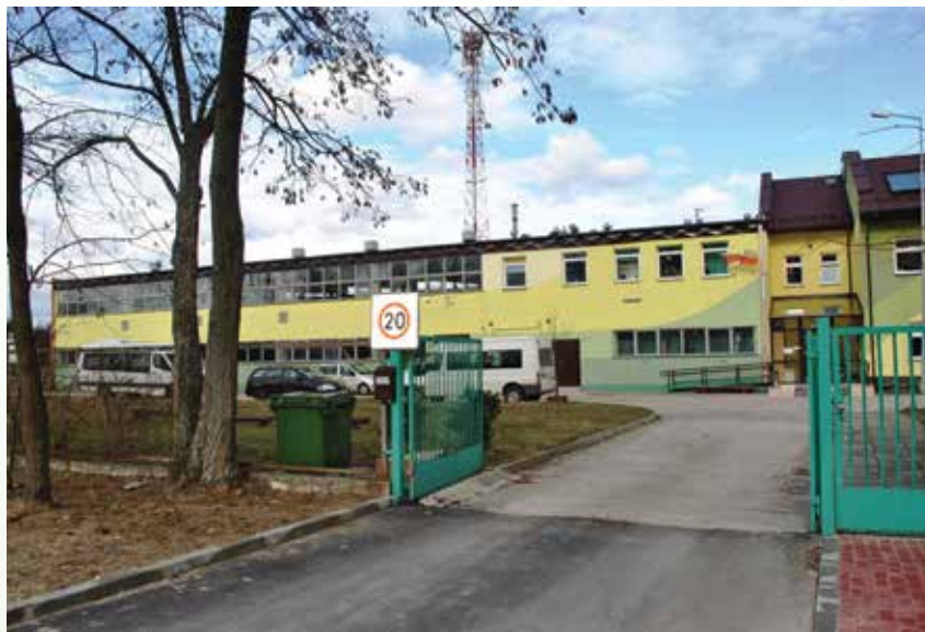
Budynek przyległy do obecnie funkcjonującego z przeznaczeniem na adaptację pod rozszerzenie oferty i działalności WTZ w Połańcu
