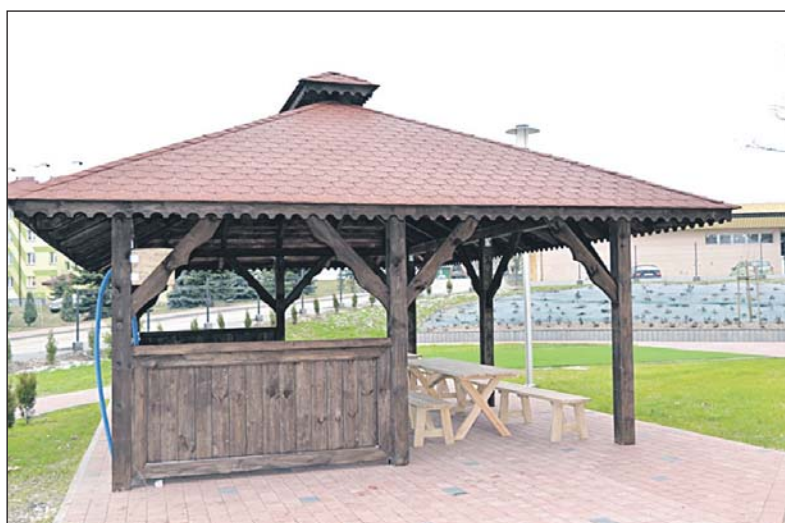
Altanka przed budynkiem
