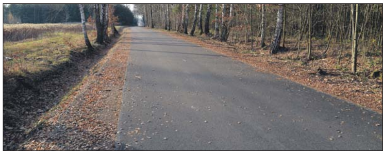
Droga w Rudnikach po remoncie
