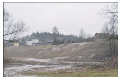
Zabezpieczona skarpy w Winnicy dzisiaj
