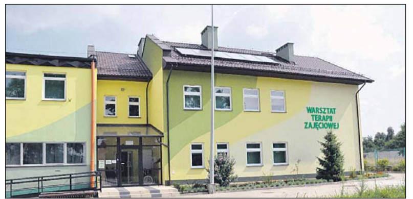
Termomodernizacja budynku Warsztatu Terapii Zajęciowej
