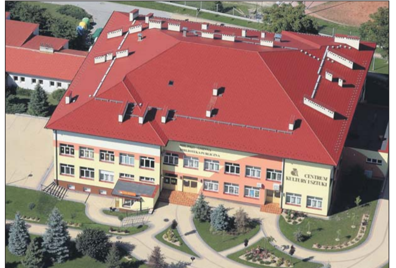
Termomodernizacja budynku Centrum Kultury i Sztuki w Połańcu
