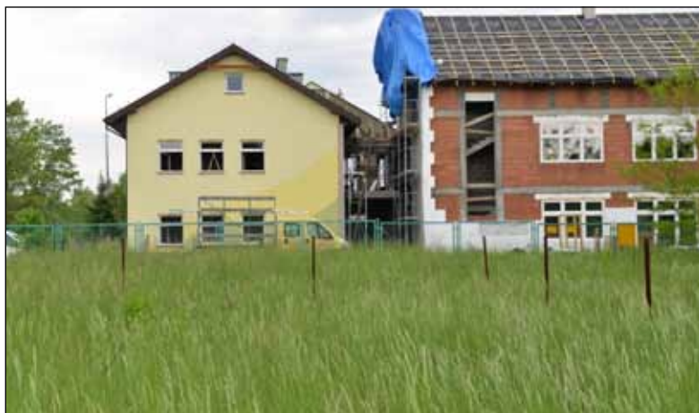
W trakcie prac
