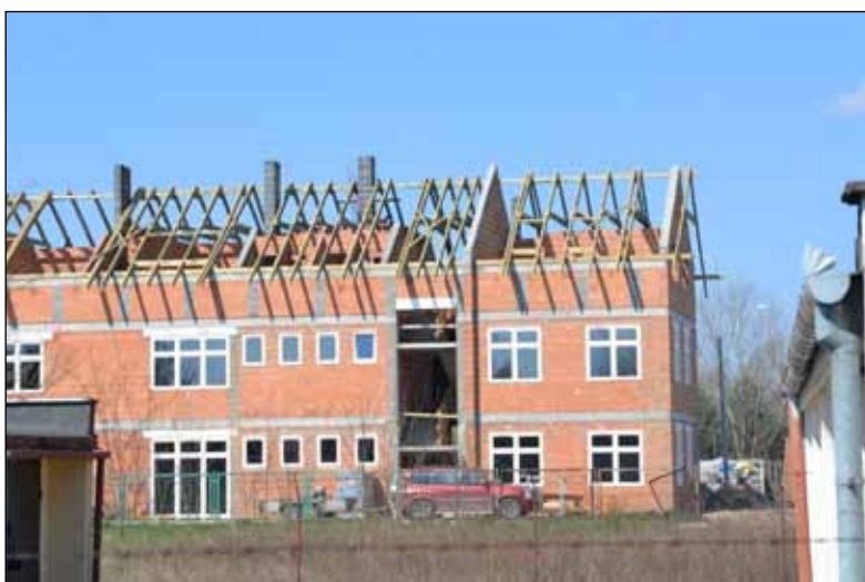
W trakcie prac
